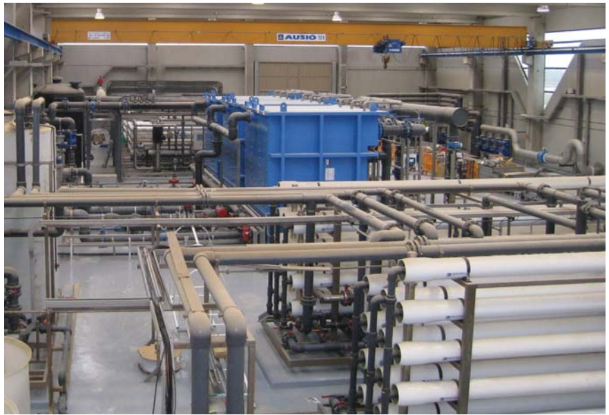
Figura 1. Vista general de las instalaciones
