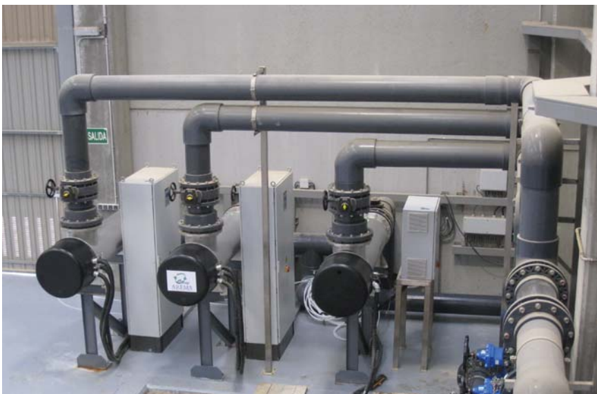
Figura 7. Detalle de las 3 (2+1 R) unidades de UV
