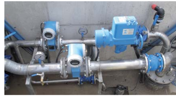
Figura 5. Detalle del equipamiento interno de un pozo
