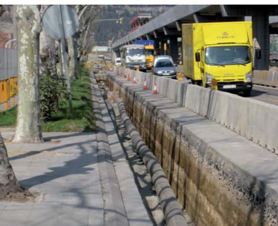
Figura 4. Detalle de la zanja de ubicación de las tuberías
